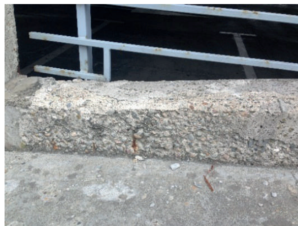
Rys. 2: Beton bez wystarczającego systemu mikroporów zniszczony przez działanie mrozu i środków odładzających
